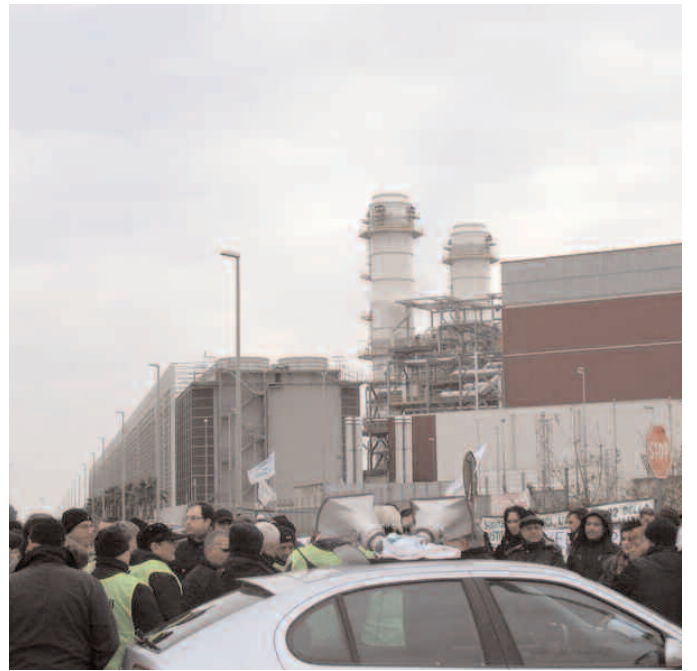
770 MW La centrale turbogas Sorgenia di Modugno è tra le più grandi d'Italia a ciclo combinato. Nella foto, una delle tante proteste dei comitati cittadini contro l'accensione dell'impianto
